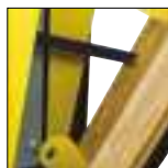
Sangles renforçant le maintien de la façade
