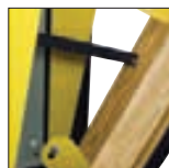
Sangles renforçant le maintien de la façade
