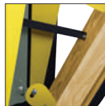
Sangles renforçant le maintien de la façade
