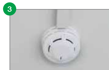
Détecteur de fumée ATEX
